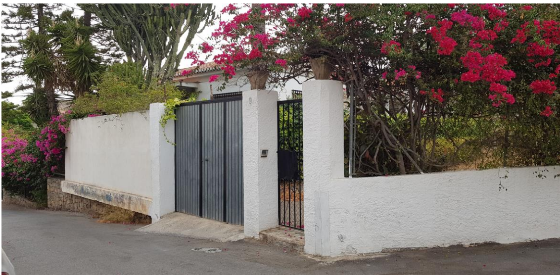
Imagen de fachada Sur.
