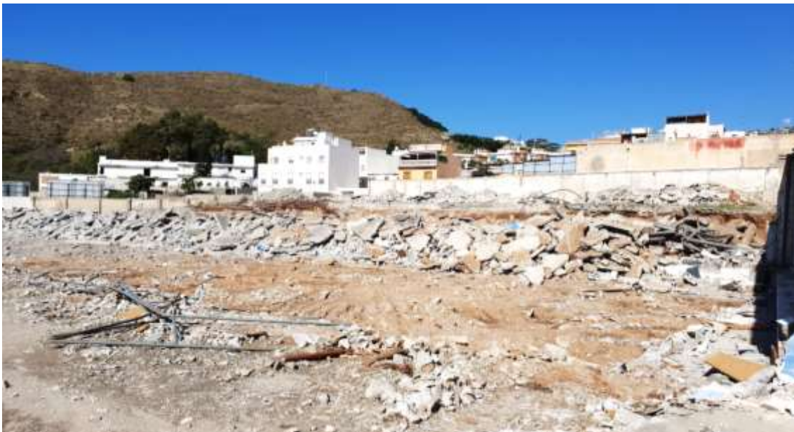
Estado actual del ARI MOT-4.
