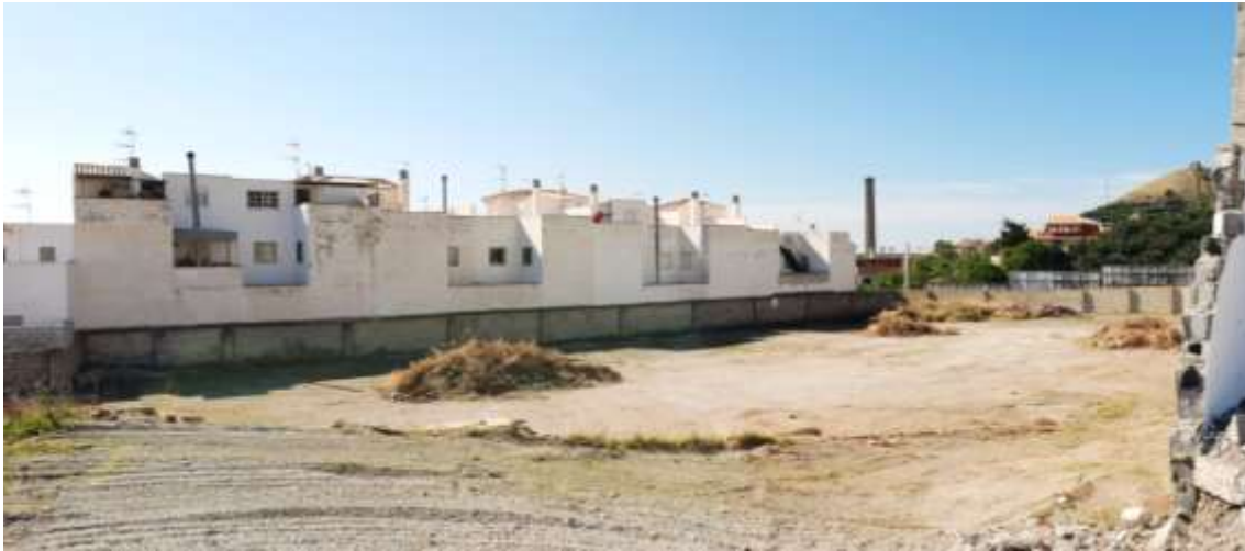
Ausencia de vegetación en ARI MOT-4. Al fondo, se aprecian los cultivos al otro lado de la Ronda de Poniente, que no se verán afectados por la Innovación.
