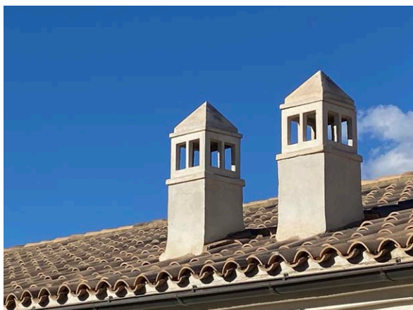
Chimeneas de ventilación baños / cubierta inclinada teja / pasillo acceso habitaciones P2
