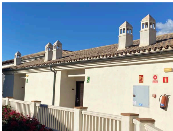
Chimeneas de ventilación baños / cubierta inclinada teja / pasillo acceso habitaciones P2
