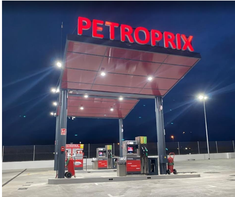
Figura 2. Gasolinera de dos marquesinas en Leganés
