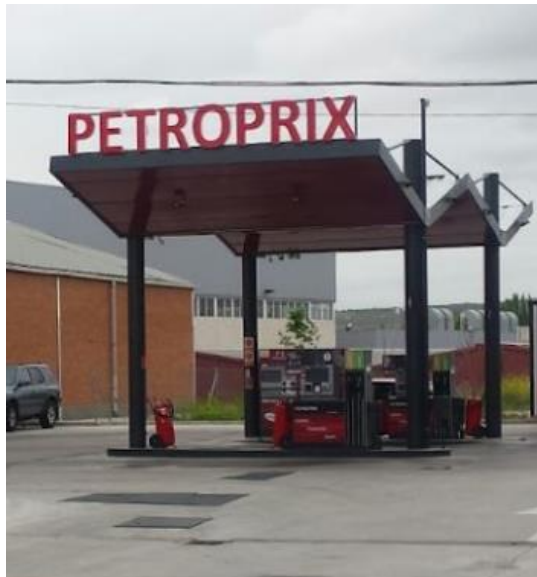
Figura 1. Gasolinera de dos marquesinas en Mejorada del Campo
