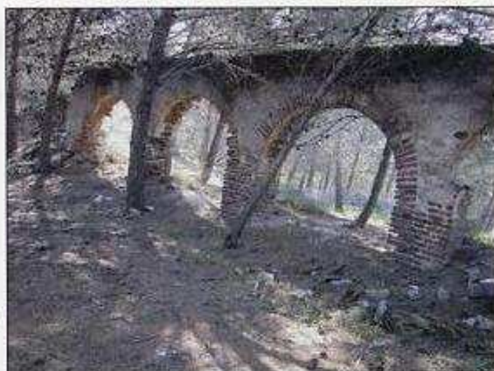
Acueducto del Cortijo Burgos.
