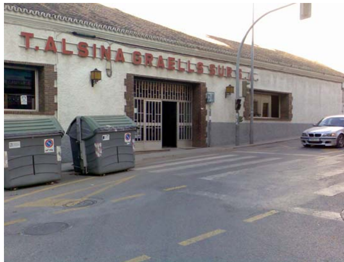
Fotografía 15 Estación de autobuses Motril
