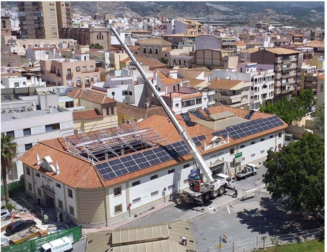
Durante y después de ejecutar actuación A.4.2b)
