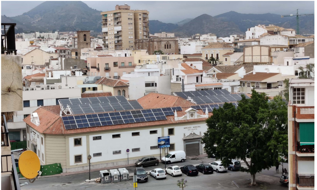
Durante y después de ejecutar actuación A.4.2b)
