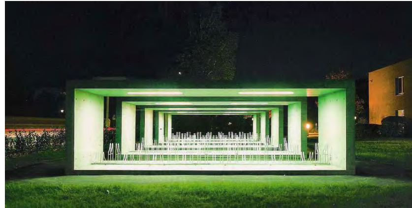
Las infraestructuras ligadas a la movilidad cicloturística y peatonal, referencias básicas. L3P Architekten. Aparcamiento para bicicletas, Zürich, Suiza.
