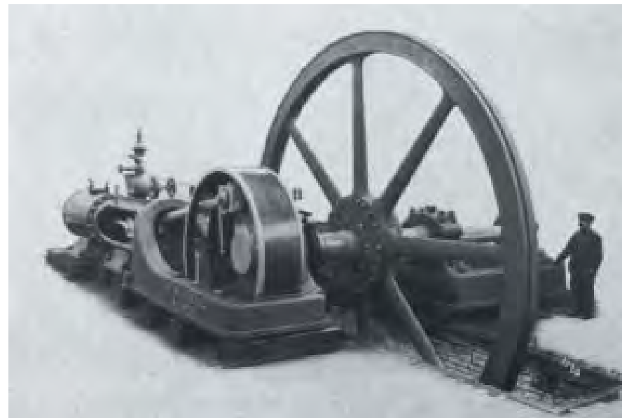
Máquina de vapor horizontal utilizada para movimiento de los molinos. Catálogo de la Cía. Fives Lille (1930). (De Álbum Fotográfico de Javier Piñar Samos –Miguel Giménez Yanguas).
