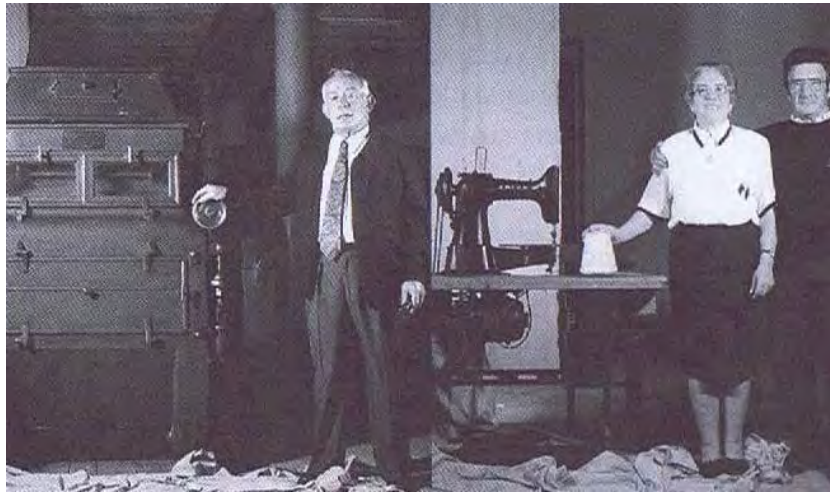
Antiguos operarios de una fábrica de Oporto, posando tras su cierre.
