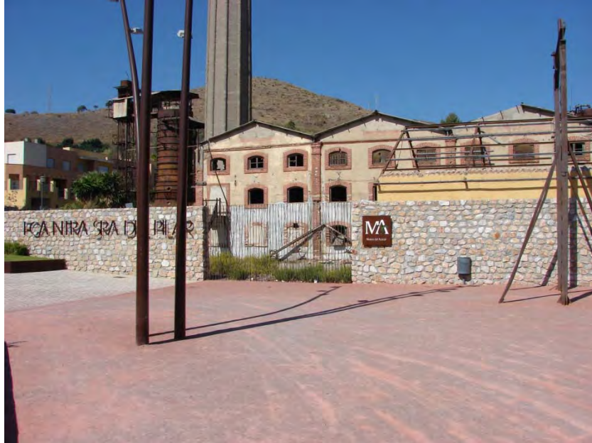
Trabajo de campo realizado en octubre de 2013. Fotografiado sistemático de edificios e instalaciones.
