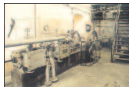
I.8.A.j Fotografía: Fábrica azucarera San Luis, máquina de vapor y bomba de vacío del sistema de evaporación.
