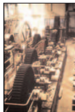
I.7.C.b Fotografía: Fábrica Azucarera Ntra. Sra. del Pilar (Motril), vista parcial Nave de Molinos, antes del desmontaje (reductores).
