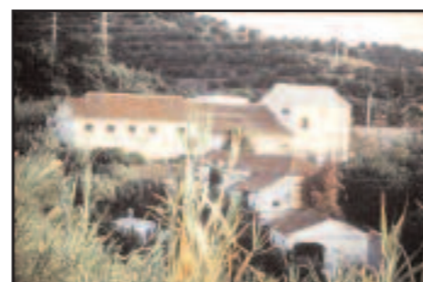
I.8.A.d Fotografía: Ruinas de la Fábrica Azucarera Sta. Isabel (Motril).
