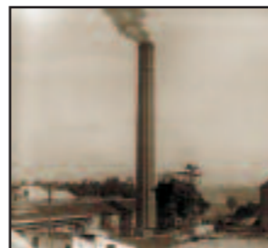
I.7.A.m Fotografía: Fábrica del Pilar, chimenea nueva (CA. 1930).
