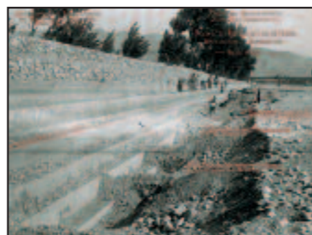
I.4.E.i Fotografía: Obras de encauzamiento del río Guadalfeo en su tramo final (1946).
