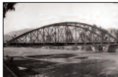
I.6.F.k Fotografía: Antiguo Puente de hierro sobre el Guadalfeo.
