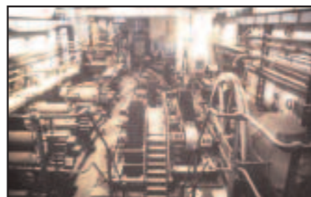
I.7.E.h Fotografía: Fábrica Ntra. Sra. del Pilar, nave de molinos antes del desmontaje.
