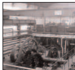
I.7.A.l Fotografía: Máquina de vapor y reductores de la Sala de Molinos (CA. 1930).
