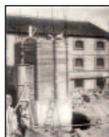
I.7.B.b Fotografía: Construcción de la chimenea de la Fábrica del Pilar.
