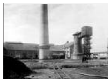
I.6.B.n Fotografía: Señorío de Lánchar. Chimenea y calera de la fábrica de azúcar (1906).
