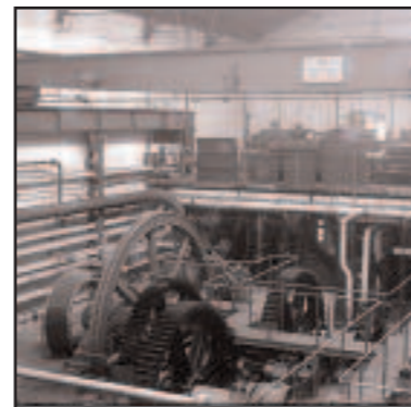
I.7.E.a Fotografía: Fábrica Ntra. Sra. del Pilar, máquina de vapor y reductores de la Nave de Molinos.
