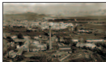
I.7.E.l Fotografía: Fábrica Ntra. Sra. del Pilar, desde la chimenea (CA. 1960).
