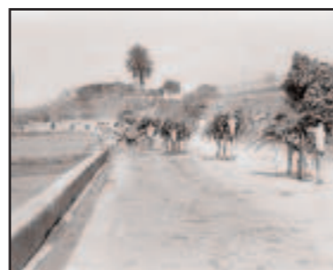
I.2.E.b Fotografía: Acarretos en el camino de la acequia (CA-1930).
